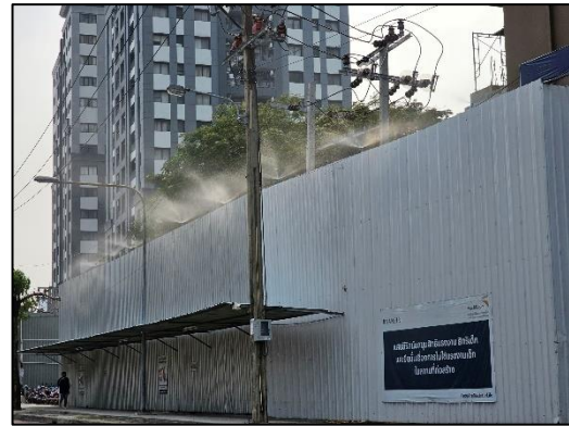
ภาพที่ 14 สเปรย์น้ำบริเวณด้านบนรั้ว Metal Sheet
