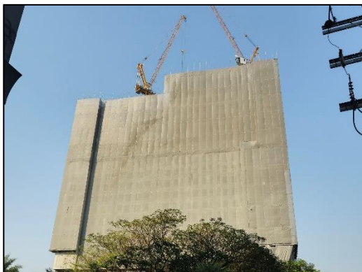
ภาพที่ 5 ผ้าใบกันฝุ่น (Mesh Sheet) ชนิดกันไฟลาม
